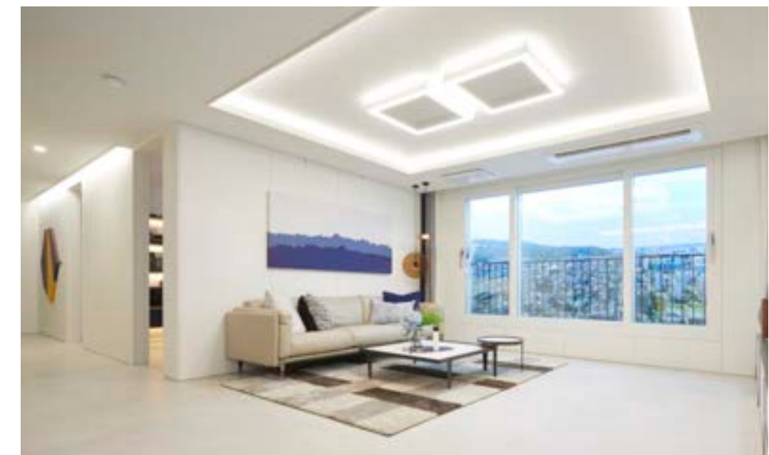
거실 우물천장 내 간접조명, 리니어 조명, 픽처레일, 시트패널
